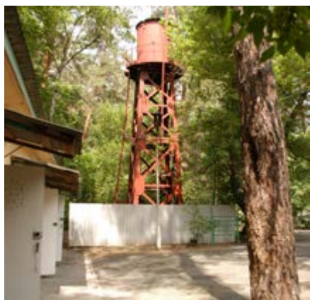
1970г.- водонапорная башня 16 м. высота на 25мЗ.
